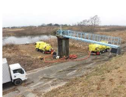
大巻取水場樋管ゲート歩廊
