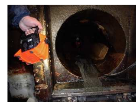
樋管（φ800mm）土砂除去状況
