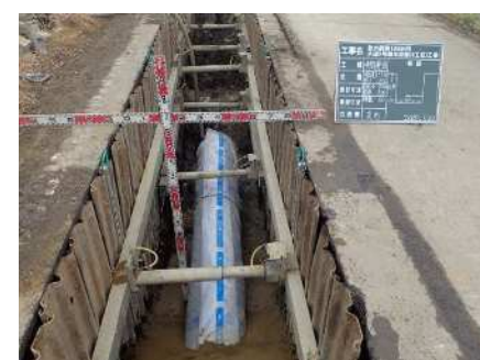
米山町字善王寺沼田地内 水道2号線 水道管（口径400mm）布設状況
