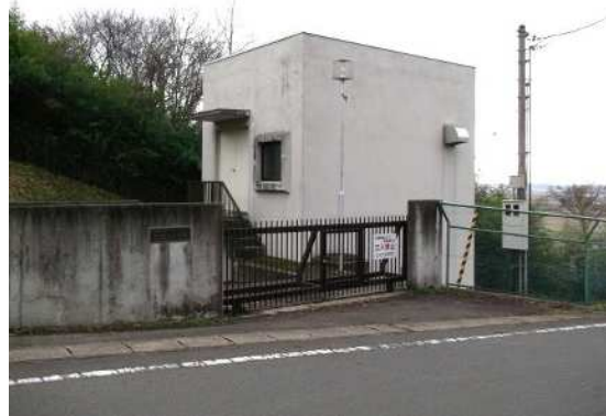
愛宕中継ポンプ場全景
