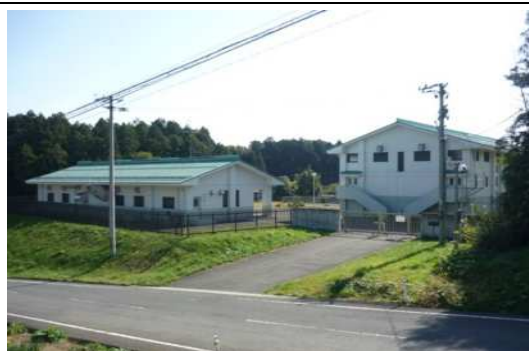
図. 石越浄水場全景
