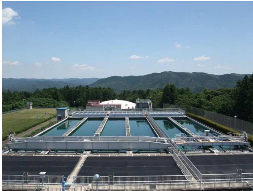
図. 保呂羽浄水場沈殿池風景
