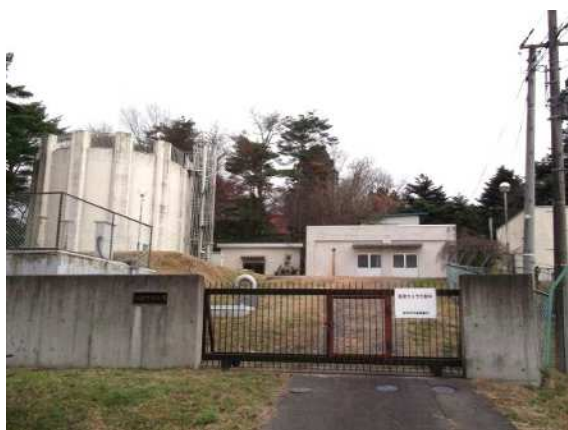
石越配水池全景
