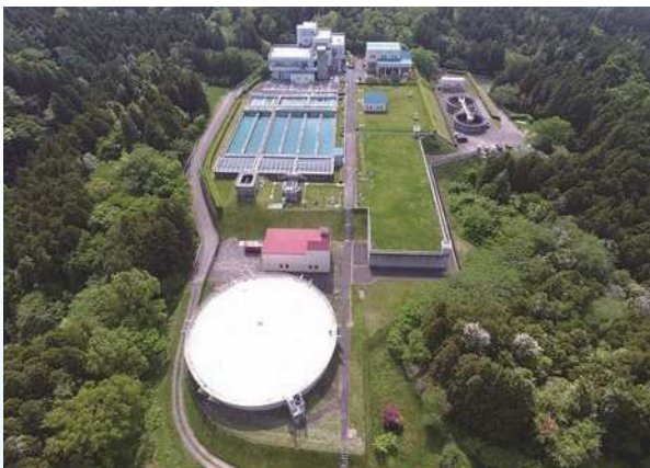
老朽化が進む保呂羽浄水場
