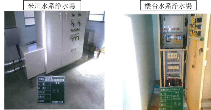
本工事は東和町の錦織及び楼台水系浄水場に新たに取水流量計を設置したものです。また、各浄水場の電気計装盤の更新を行い、新たな通信設備に改良し、各水系からのきめ細かい情報が保呂羽の中央管理室に伝送される設備に整備しました。取水量の常時監視により、安定した浄水処理が可能となりました。
