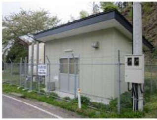
合ノ木浄水場
