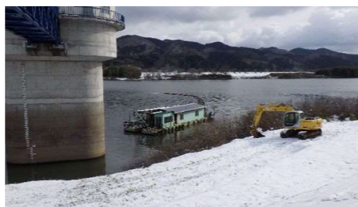
【浚渫作業状況】
