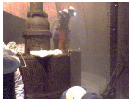
【取水ポンプに上り作業している様子】
