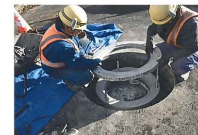
【マンホールの高さ調整の状況】
