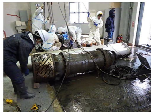
【ポンプ搬出作業状況】
