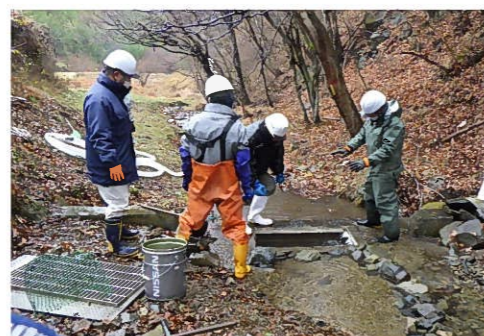
【合ノ木取水口作業状況】
