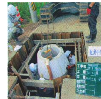
【中田町石森地区汚水管渠築造工事状況】
