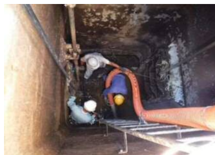
【接合井清掃状況】
