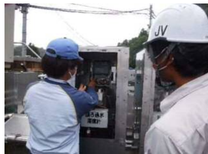
【水質計器点検状況】
