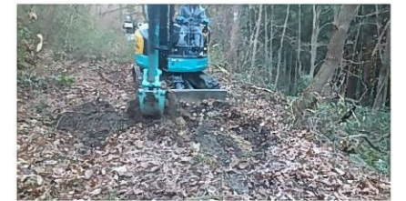
漏水箇所を掘削している様子
