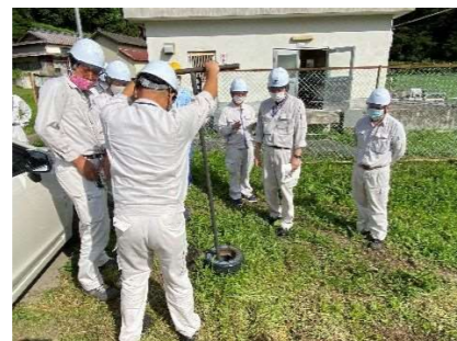
【仕切弁操作状況】
