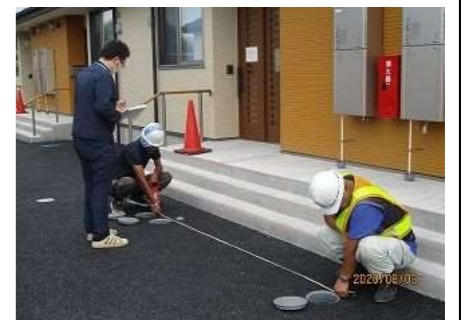
(検査を行っている様子)
