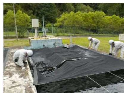
【2号ろ過池遮光ネット設置状況】
