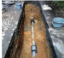
【復旧工事の状況】
