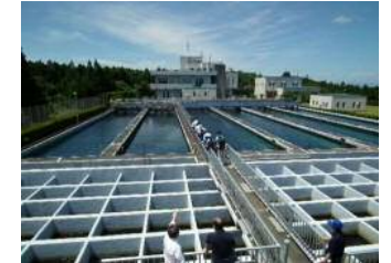
【現地調査(保呂羽浄水場)の様子】
