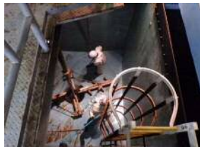
【沈殿池内清掃作業状況】
