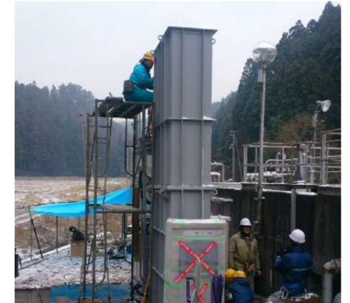
保呂羽浄水場等管理運転業務受託者からの提案で錦織浄水場でのセラミック製膜ろ過設備の実証試験が行われています。一般的に設置されている膜処理装置は、科学繊維を用いたものが多く、その強度や短命による交換経費等のランニングコストに課題があるために、近年開発されたセラミック平膜ユニット型膜処理装置は高耐性、高強度、膜破断の無い長寿命型の装置としてランニングコスト等の軽減を目指し開発された装置です。将来の錦織浄水場更新時に新たな水処理方法として期待できることから、実証試験の場所を提供したもので、16日から23日かけてメーカーが設置し、来年の8月まで実証試験が行われます。
