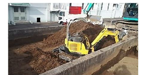
汚泥を搬出している様子
