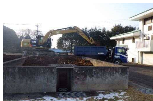
【石越浄水場汚泥積込作業状況】
