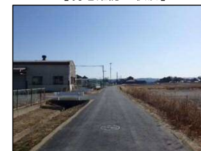
【舗装本復旧の完了】
