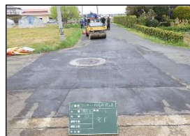
【施工完成後の状況】
