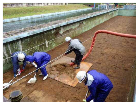
【2号ろ過池砂掻き取り作業状況】
