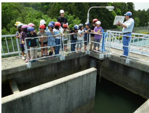
北上川の原水が始めに届く着水井を見学しました。（佐沼小学校）
