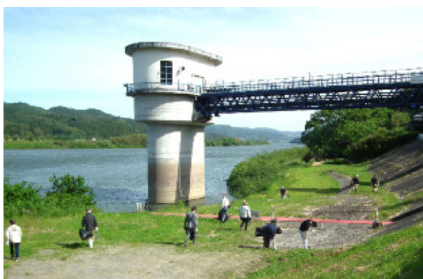
【取水塔付近 ごみ回収の様子】
