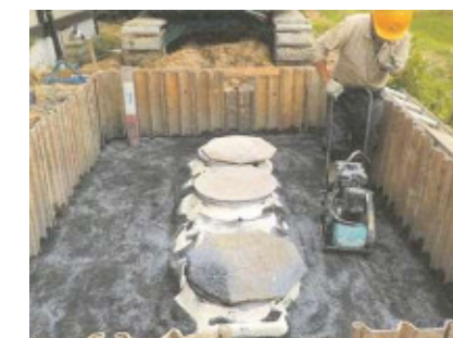
【浄化槽設置工事状況】
