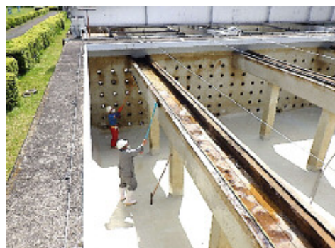
【清掃作業している様子】
