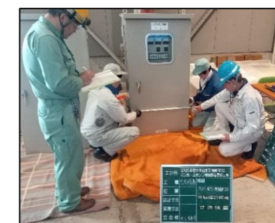
【工場検査状況】
