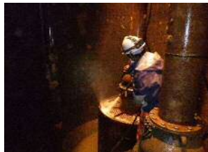
【取水ポンプ清掃作業状況】
