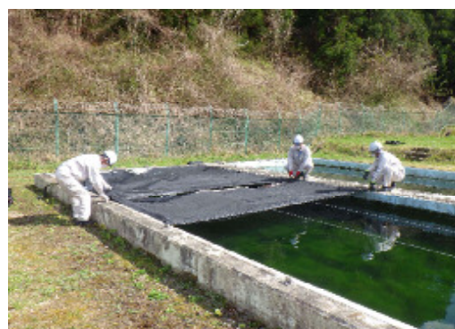
【遮光ネット設置状況】
