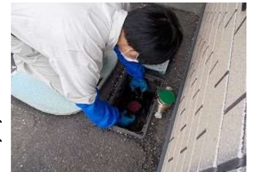
(メーター交換を行っている様子)
