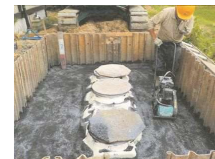
【浄化槽設置工事状況】
