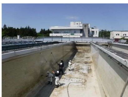
【1号沈殿池清掃作業状況】
