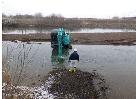
【浚渫作業状況】
