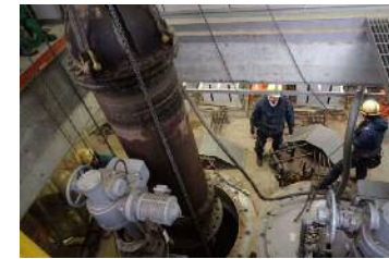
4号取水ポンプ撤去状況
