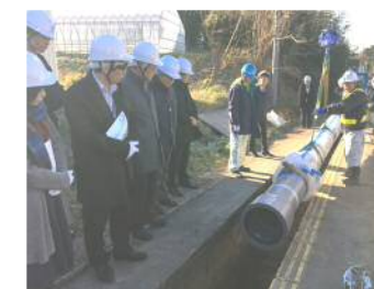
布設工事現場視察
