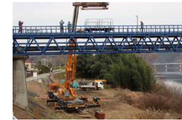
クレーン作業(搬出・搬入)
